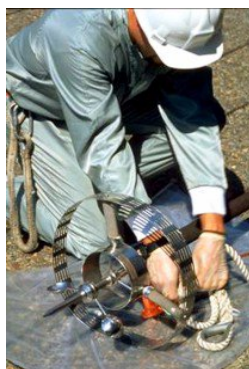
Retirada Cabezal Pararrayos Radiactivo
