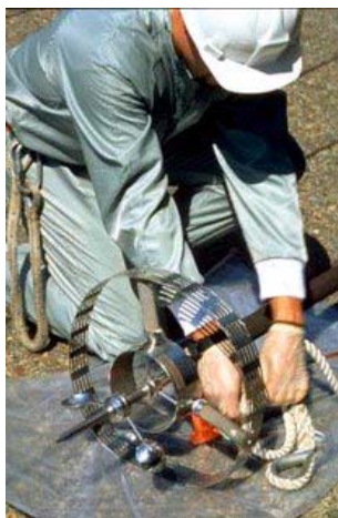
RETIRADA DE UN CABEZAL DE PARARRAYOS RADIATIVOS
