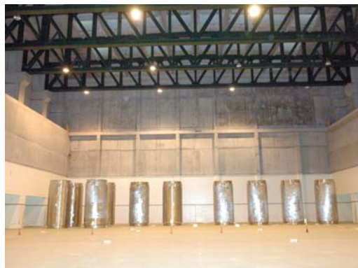
FIGURA 7. ALMACÉN C.N. TRILLO (Finales 2005)
